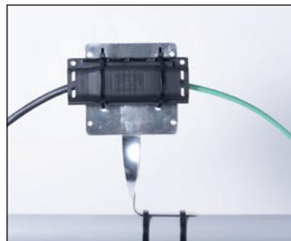
Zwei Kabelbinder Nr. 3 durch je beide Bohrungen durchschleifen und über Gelmuffe festziehen. Die Kabelüberstände mit dem Seitenschneider abschneiden.
